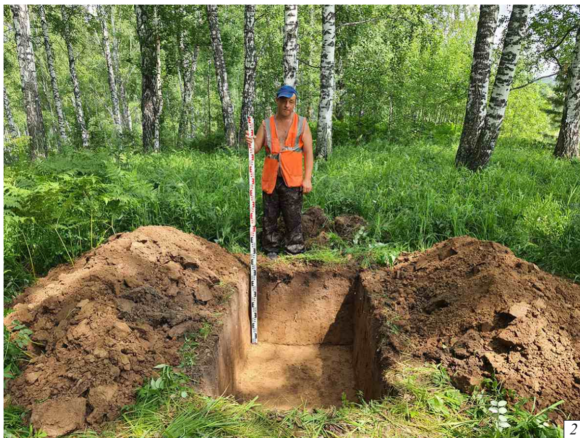
Рис. 152. Археологическое обследование земельного участка, подлежащего воздействию земельных, строительных, хозяйственных и иных работ для разработки раздела проектно-сметной документации по объекту «Межпоселковый газопровод п.Металлплощадка - с.Старочервово Кемеровского муниципального района Кемеровской области» расположенном в Кемеровском муниципальном округе Кемеровской области. Шурф № 6. 1 - разметка. 2 - после выборки. Везде вид с юга.
