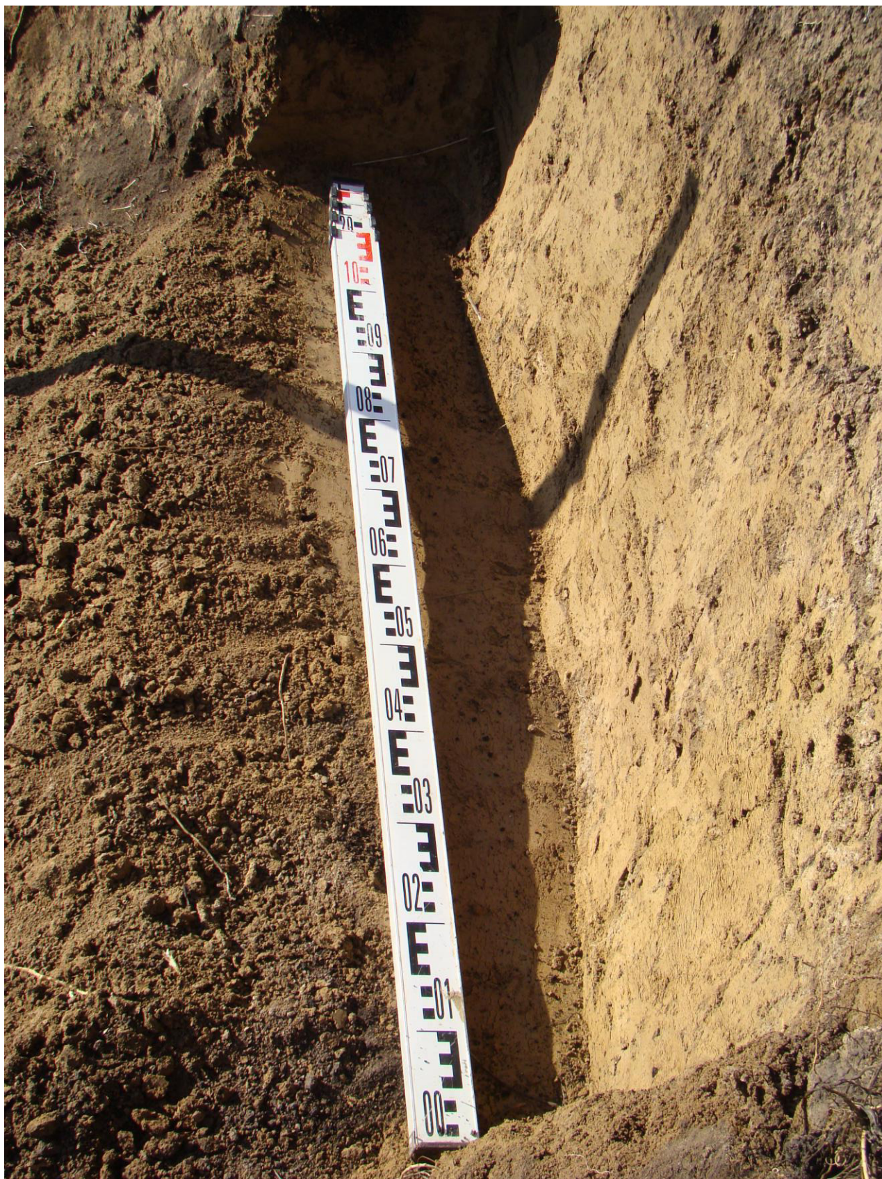
Рис. 39. Шурф-зачистка № 6 после выборки. Фото с Ю.
