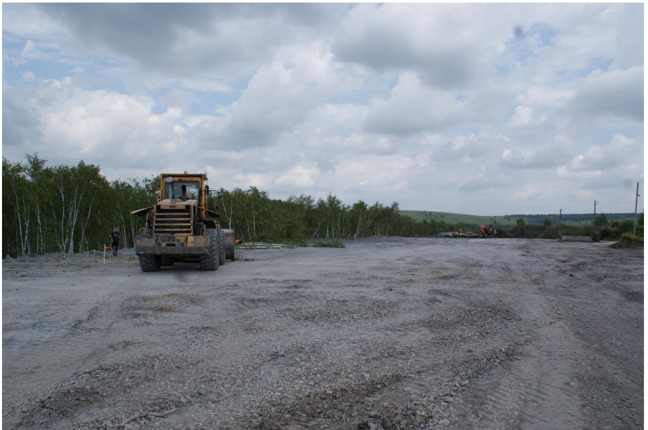
Рис. 10. Восточная часть земельного участка. Фото июль 2017 года. Работы по строительству путей уже ведутся.
