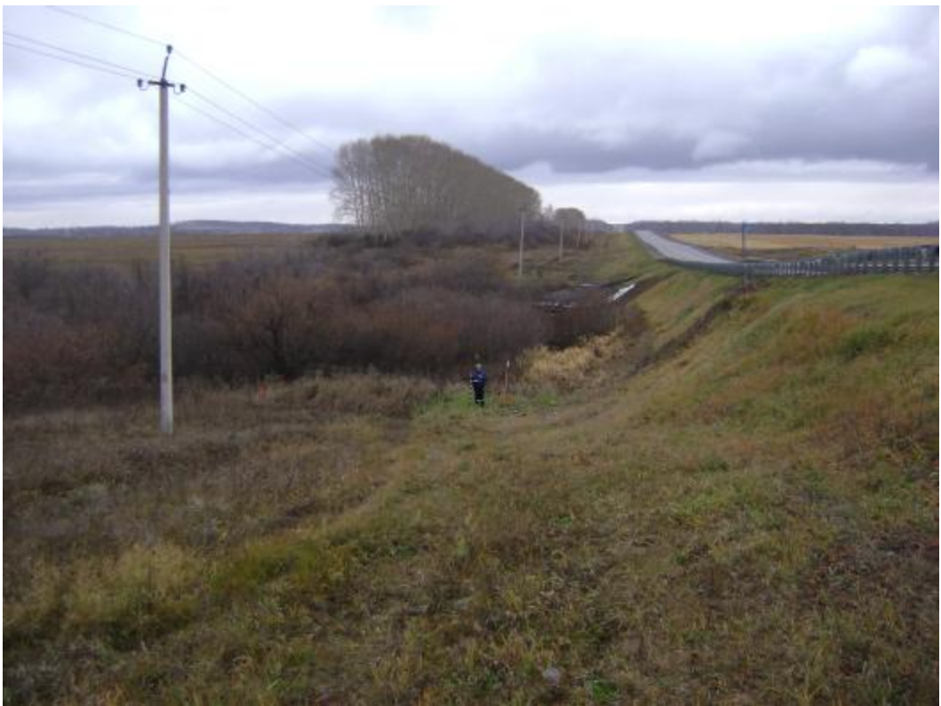
Рис. 67. Вид на землеотвод проектируемый под обьездную дорогу №2 и обнажения грунта на автомобильной дороге Р-255 «Сибирь» справа от ручья правого притока р. Курляк.. Фото с В стороны.
