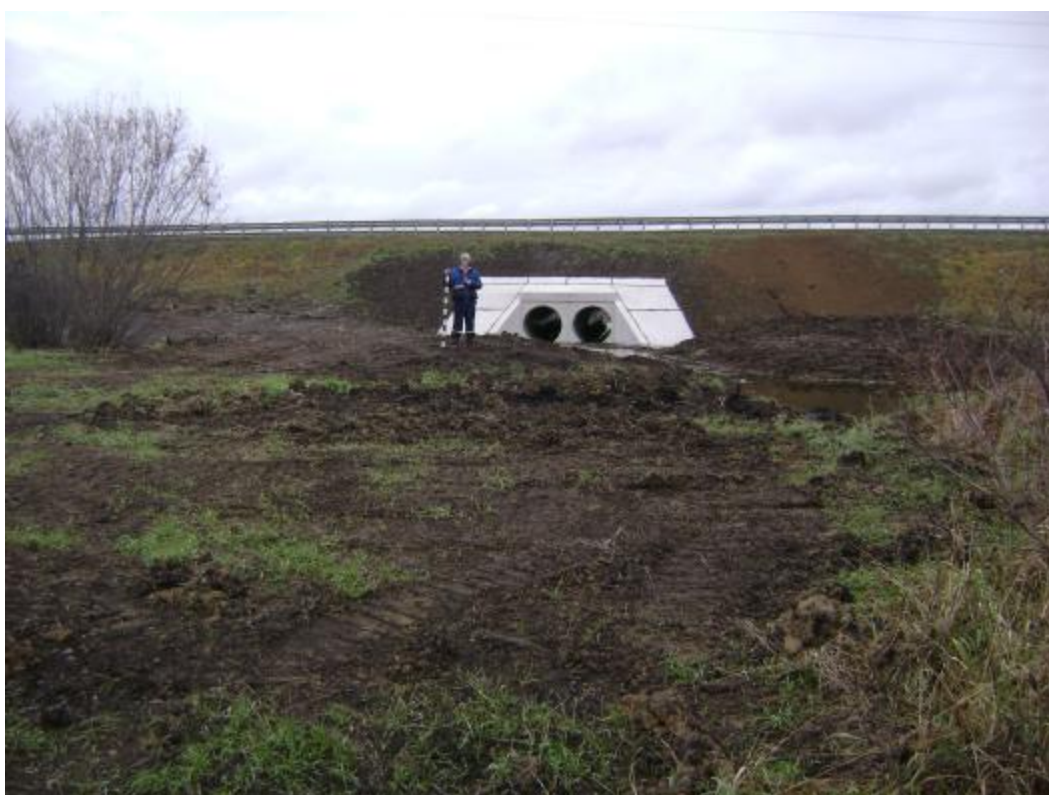
Рис. 58. Вид обнажения грунта на землеотводе проектируемого под обьездную дорогу №2 на автомобильной дороге Р-255 «Сибирь», слева от ручья правого притока р. Курляк. Фото с Ю стороны.
