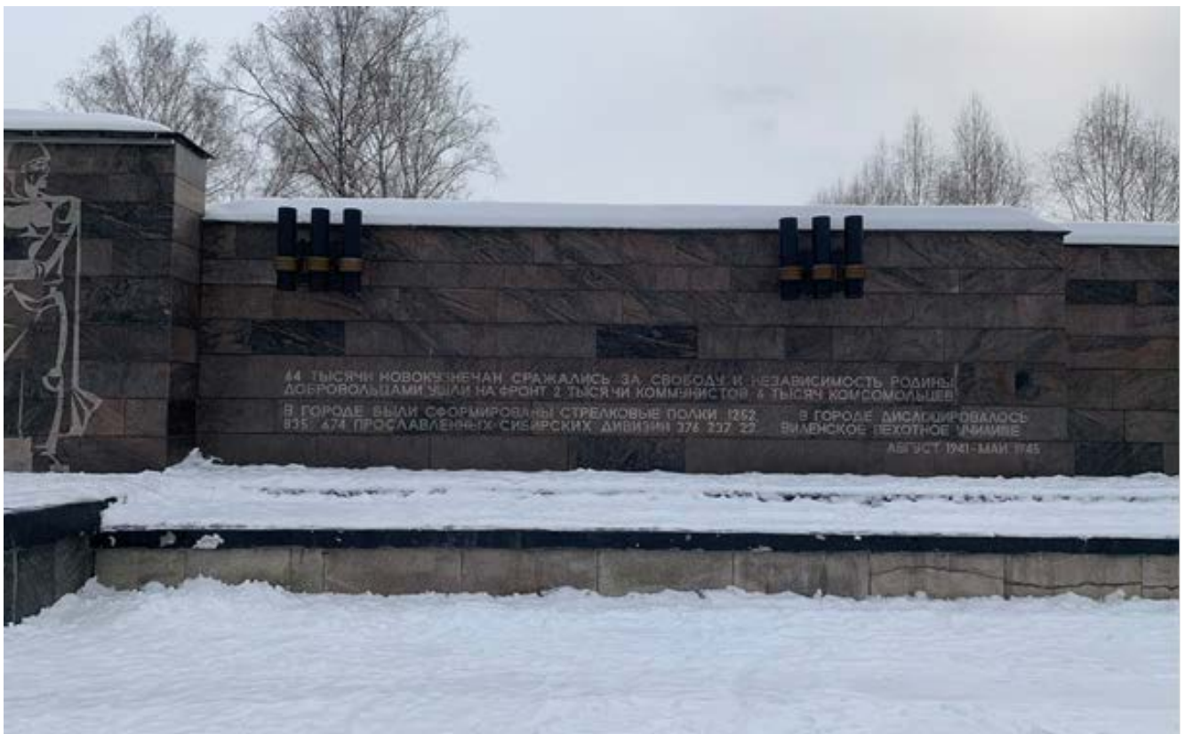
Фото № 4. Объект культурного наследия «Мемориальный комплекс «Бульвар Героев». Мемориальная стена с трибунами. Главный фасад (фрагмент композиции «Тыл-фронту»). Взгляд с площади. Фото март 2024 г.
