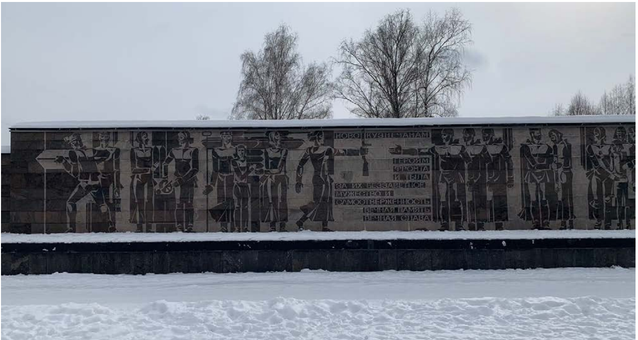
Фото № 1. Объект культурного наследия «Мемориальный комплекс «Бульвар Героев». Мемориальная стена с трибунами. Главный фасад (фрагмент композиции «Тыл-фронту»). Взгляд с площади. Фото март 2024 г.
